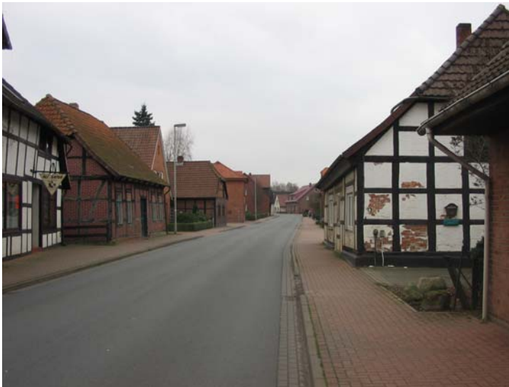
Abb. 29: Gerade in den alten Siedlungskernen drohen Instandhaltungsrückstände und Leerstand, vor allem an den lärmbelasteten Ortsdurchfahrten (Foto: FORUM GmbH, Dezember 2006)
